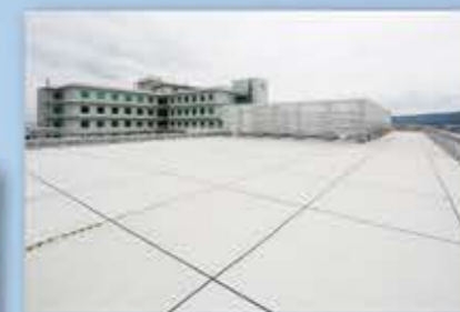
地域住民の一時避難スペース(屋上 640人収容)
